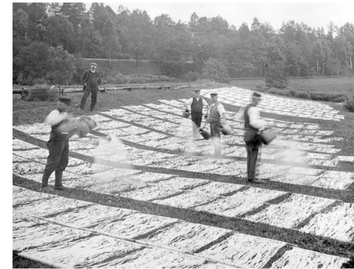
Rasenbleiche: Besprengen ausgelegter Garnpartien zur Garnaufbereitung in der Leinenindustrie, ca. 1910
