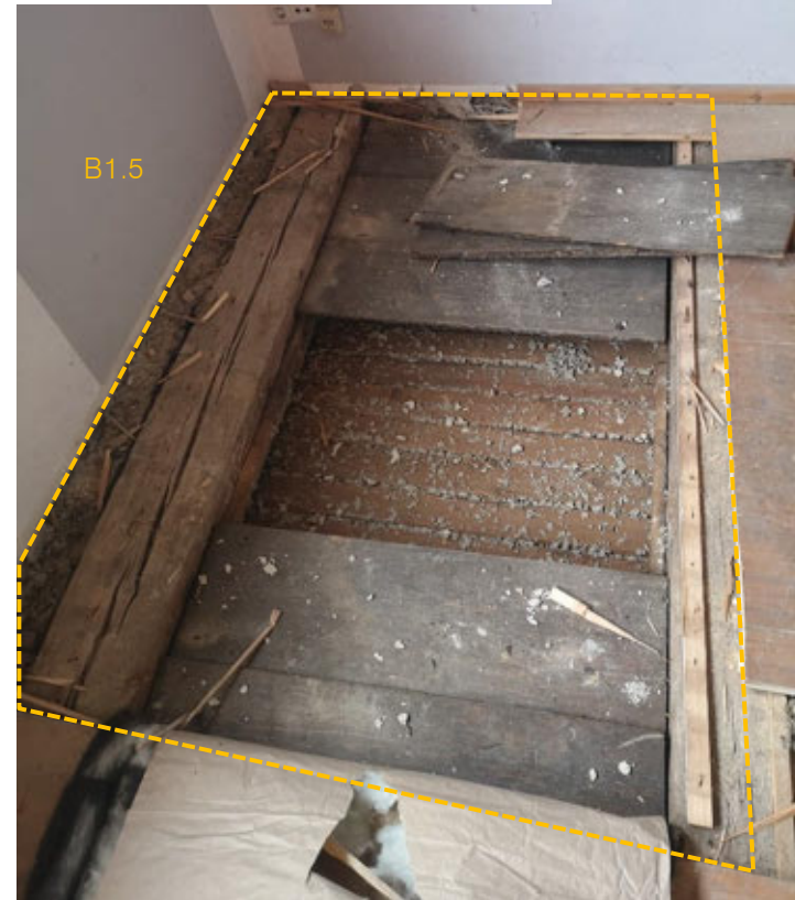
2: Blick auf Bodenöffnung B1.5: Deckenbalken spannen in W-O-Richtung; Fehlboden ohne Schüttung; Einschubbretter liegen auf angenagelten Leisten.
