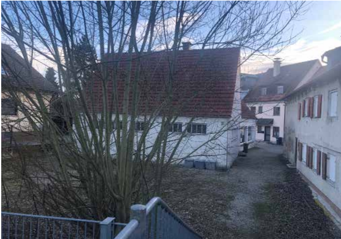
Blick von der Brücke aus in den östlichen Bereich der Außenanlagen
